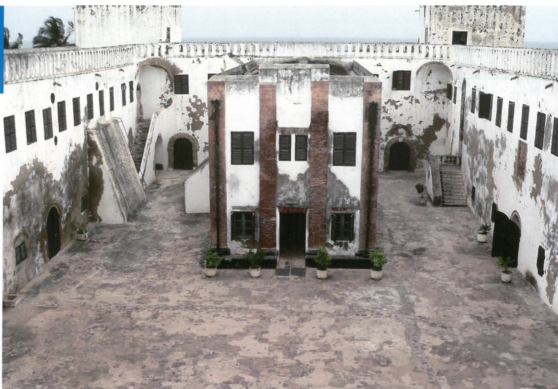
De binnenplaats van fort Elmina, Ghana.
