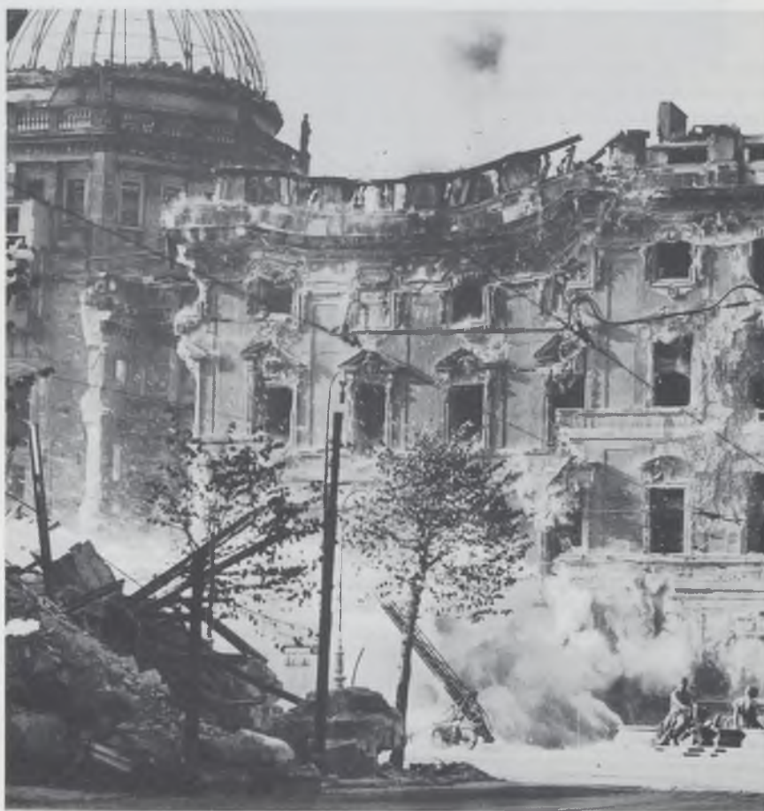
In 1950 werden de ruïnes van het stadskasteel opgeblazen.
