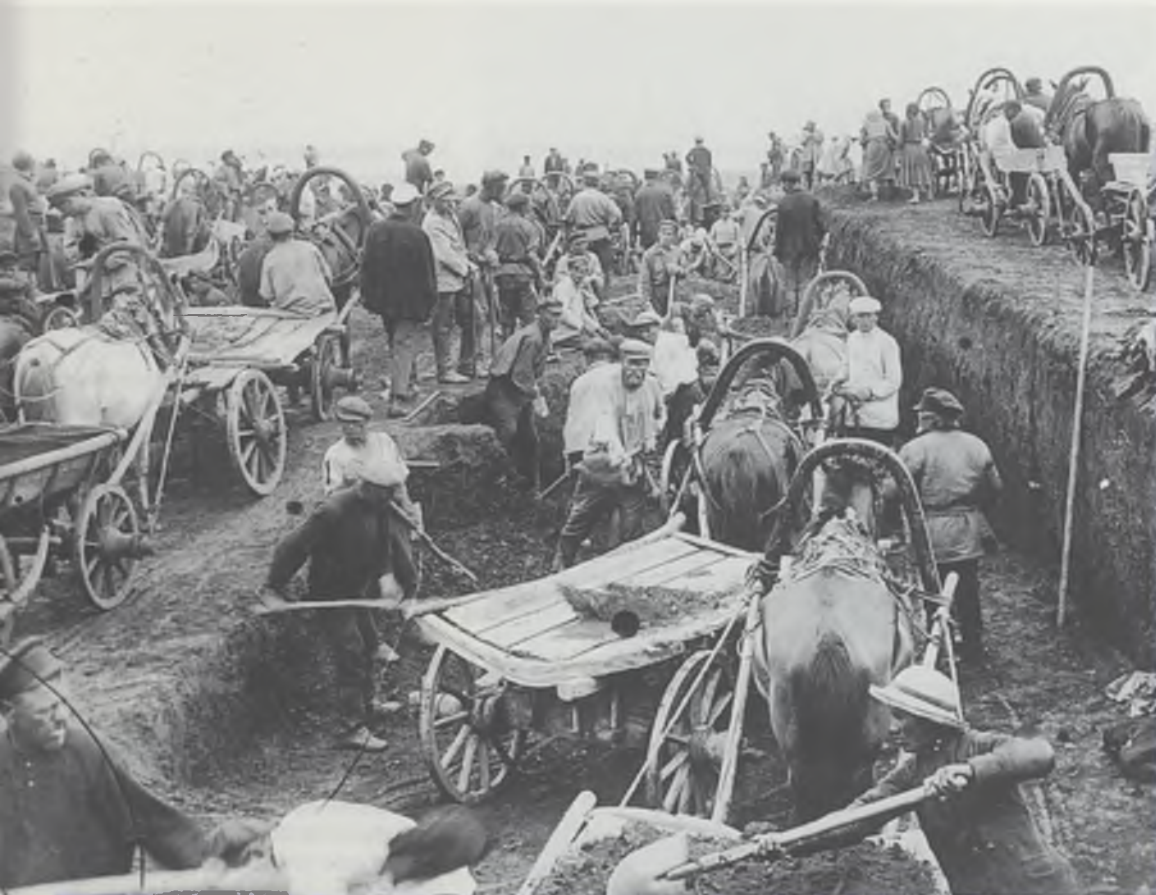
De bouw van het nieuwe staalcentrum Magnitogorsk, circa 1934. Funderingen worden met de hand gelegd. Het zwaarste werk werd gedaan door veroordeelde 'koelakken' en andere 'speculanten' en 'parasieten'. (foto uit: De eeuw van Rusland, 168)
