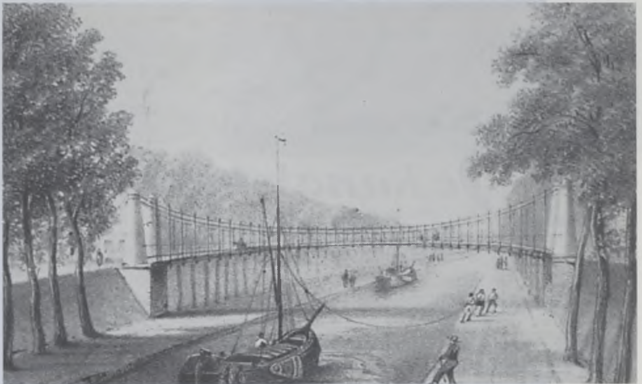
Het kanaal Pommeroeul-Antoing, 1846. Op de voorgrond een gietijzeren hangbrug en daarvoor een schip dat met de hand wordt gejaagd.
