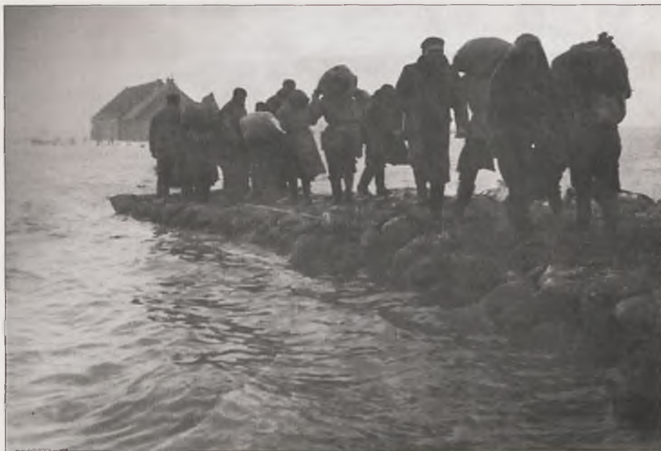
Mannen uit Stad aan 't Haringvliet bezig met het dichten van een gat in de binnendijk bij hun dorp. (Uit: De Ramp. Een reconstructie)
