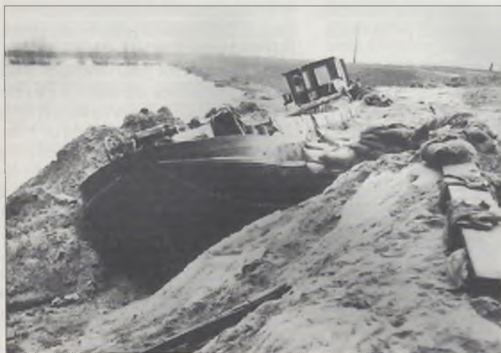
Het schip van Arie Evegroen, waarmee het gat in de Schie-landse Hoge Zeedijk werd gedicht. (Uit: De Ramp. Een reconstructie)
