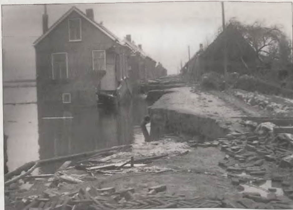
De ravage die het water aanrichtte aan de Molendijk in 's-Gravendeel. (Uit: De Ramp. Een reconstructie)
