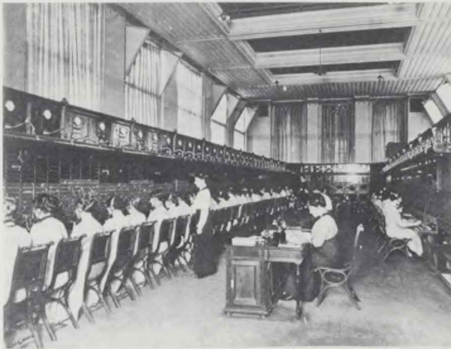
Een telefoonzaal circa 1920 (uit: Marjolein Morée en Marjan Schwegman, 'Vrouwenarbeid in Nederland 1870 - 1940').
