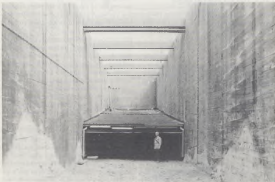
Een der vijf enorme silo's van de plofsluis in het Amsterdam-Rijnkanaal bij Nieuwegein.
