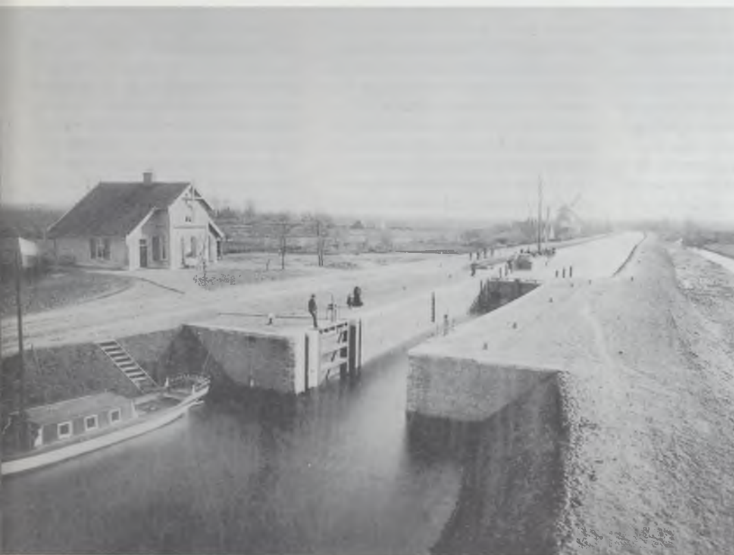
Het Apeldoorns kanaal, de Koudhoornsluis. (Foto uit de collectie van het Historisch Museum Apeldoorn 1881.) De totstandkoming van het Apeldoorns kanaal in 1829 maakte deel uit van de grote infrastructuurwerken die onder regering van koning Willem I werden uitgevoerd. Het is als een kleinschalig 19e eeuws kanaal bewaard gebleven en is nu met zijn beplanting, jaagpaden, sluizen en bruggen in cultuur-historisch en landschappelijk opzicht waardevol.
