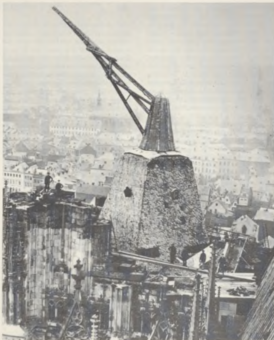
Afb. 11 Bouwkraan uit ca. 1450 op de zuidtoren van de Dom van Keulen. Foto uit 1868, vlak voor de sloop van de kraan.
