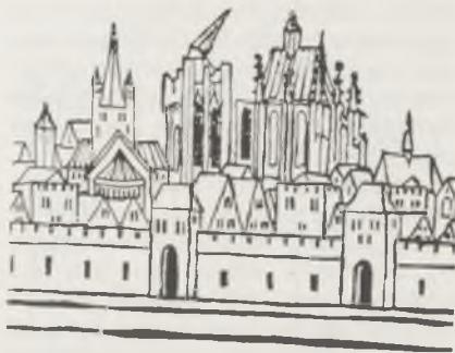
Afb. 12 Fragment van het gezicht op Keulen in de 'Chronica van der hilliger stadt Coellen' uit 1499. Duidelijk herkenbaar is de bouwkraan op de Domtoren.
