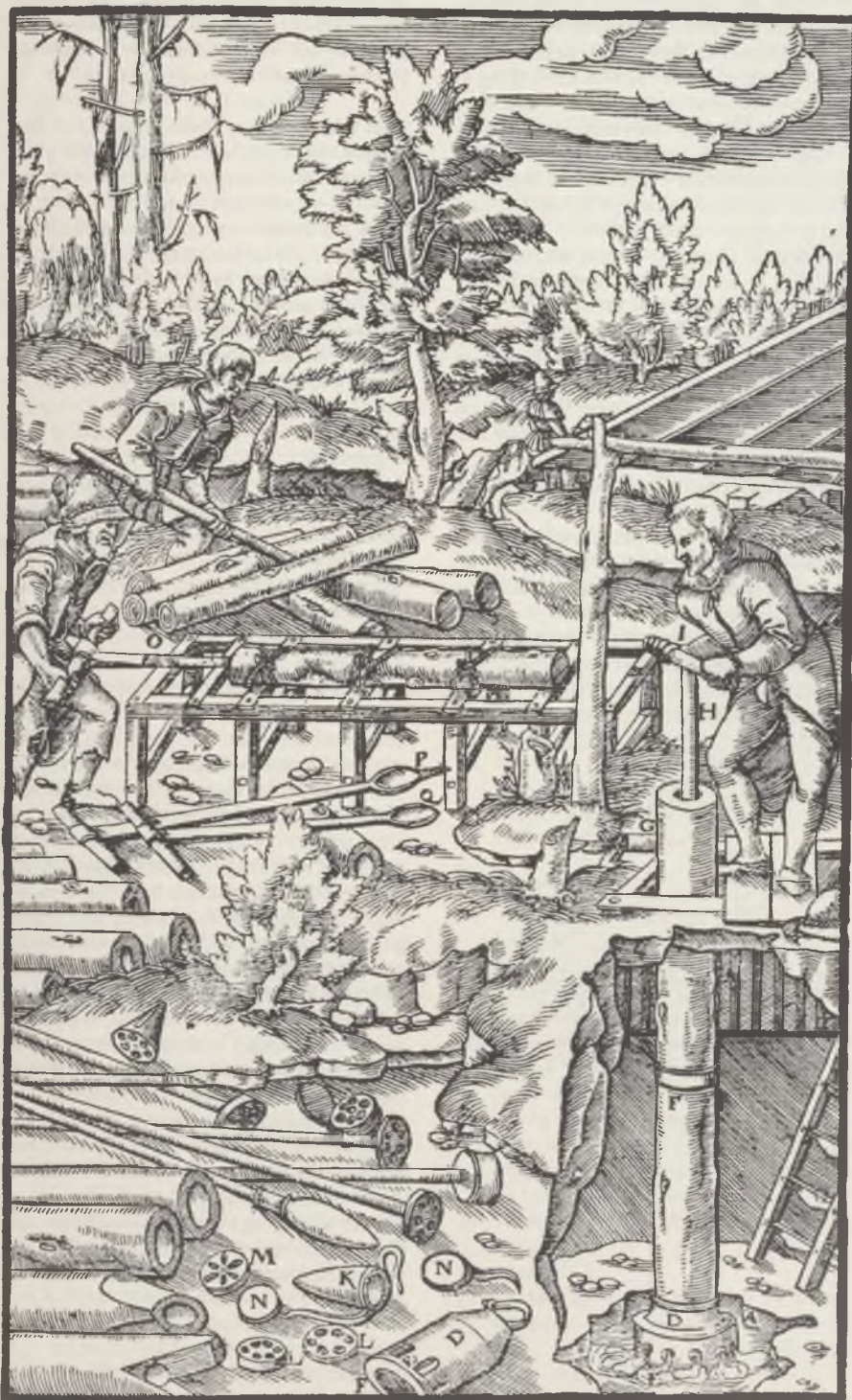
We zien zuigers ( \alpha , M); zuigers aan zuigerstangen, kleppen (N), en tussen de zuigerstangen een zuiger met klep (2)
