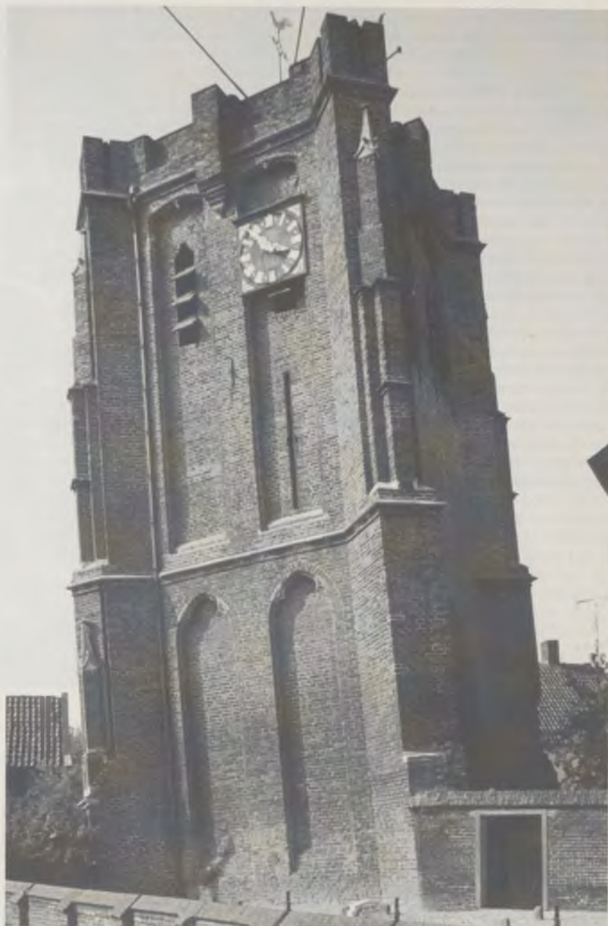
Afb. 6 De scheve toren van Acquoy (XV e). Wanneer men schuin van onderen langs de binnenhoek van de steunberen kijkt ziet men duidelijk de 'knik' tussen de eerste en de tweede geleiding.
