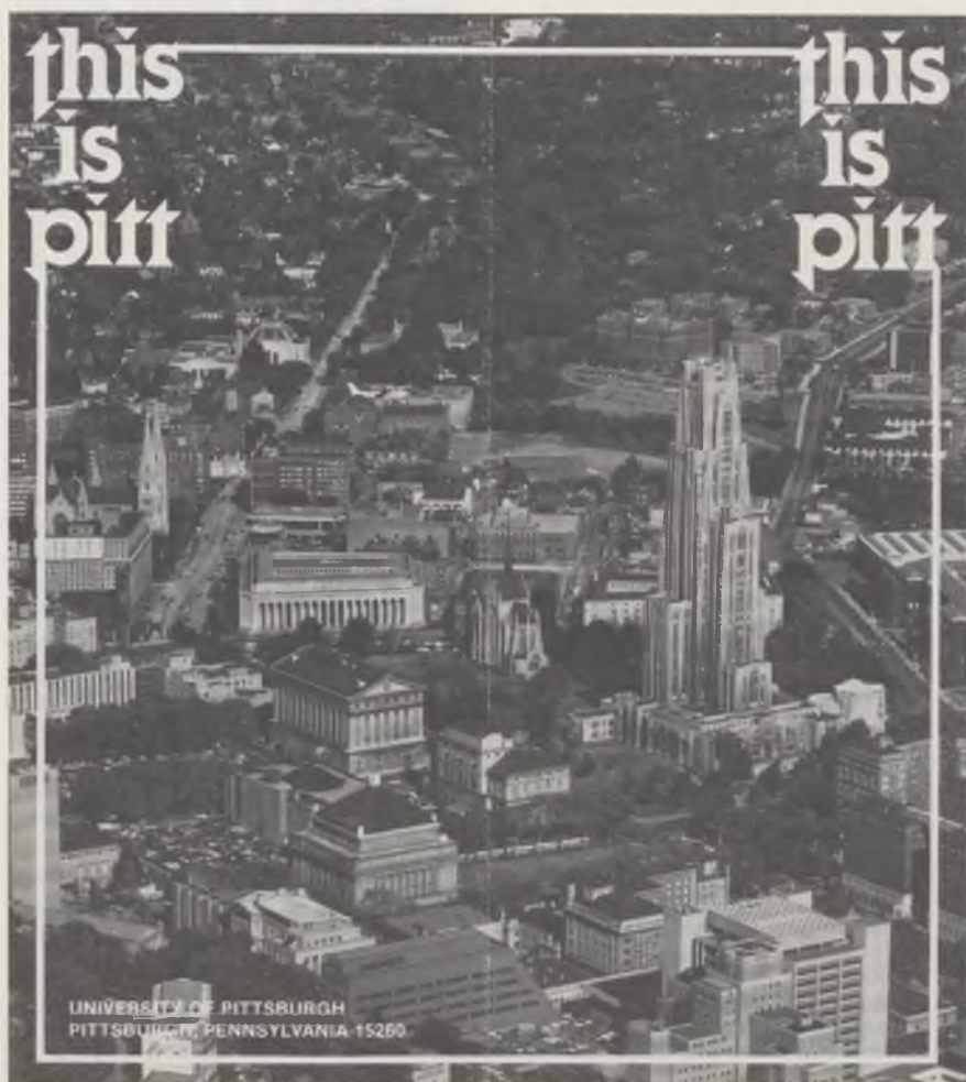
Voorbeeld van een grote campus. De (neogotische) toren is de 'Cathedral of Learning', gebouwd in 1937.
