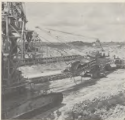
24. Bauxietwinning bij de plaats Onverdacht. Graafmachine en transportband.
