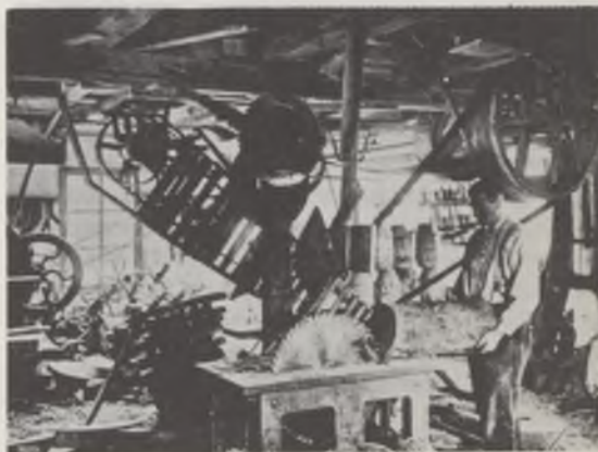
Gedeeltelijk gemechaniseerde Radmakerij met eind 19e-eeuwse ijzeren werktuigen (Foto Ned. Openluchtmuseum).
