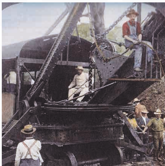
President Teddy Roosevelt liet zich fotograferen terwijl hij een graafmachine bediende bij de werkzaamheden aan het Panama Kanaal.
